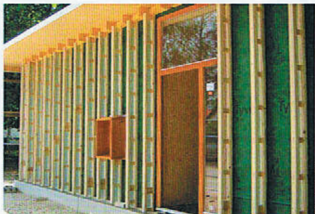
Aus Stegholzträgern aufgebaute Außenwand (ohne Dämmung und Beplankung)
